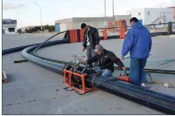
اللوحة 44 عملية اللحام المُنَاكِب الأخرية لنهائي الأنبوب، وعقب عملية اللحام هذه يكون الأنبوب الأول من طوق القفص قد أُغلق
